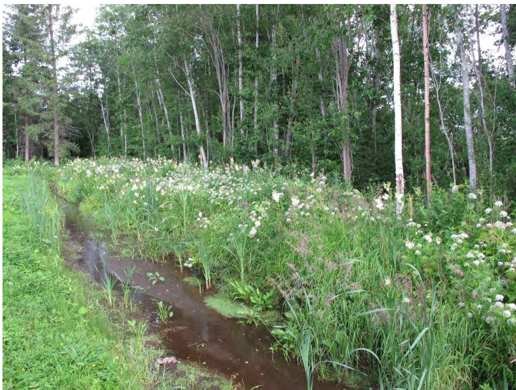
Kuva 3. Leveä kaivettu valtaoja Kinnarinkadun tonttien itäreunalla.
