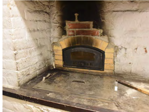
Kuva: Uunin suuaukkoa on korjailtu.
