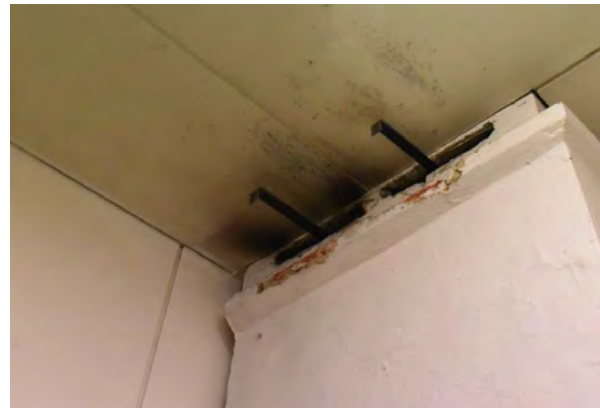
Kuva: Pellit, katto- ja seinäpinnat.
