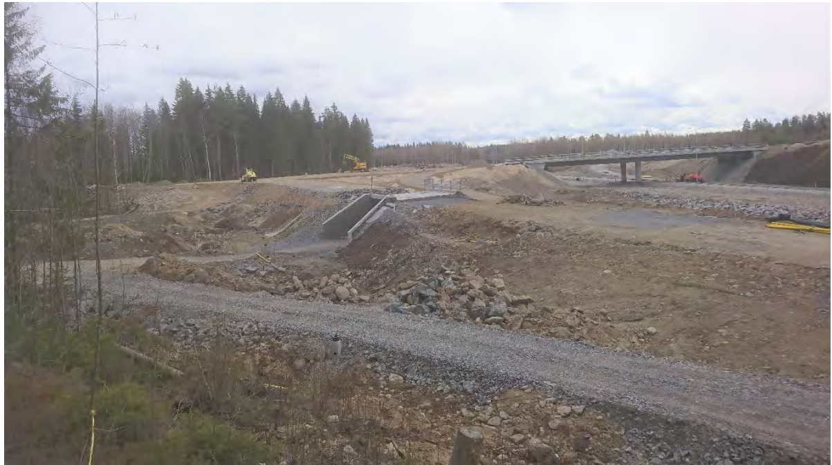
Kuva 5. Selvitysalueen metsä näkyy kuvassa taustalla. Metsän itäpuolelle rakennetaan Kinnarin eritasoliittymää.
