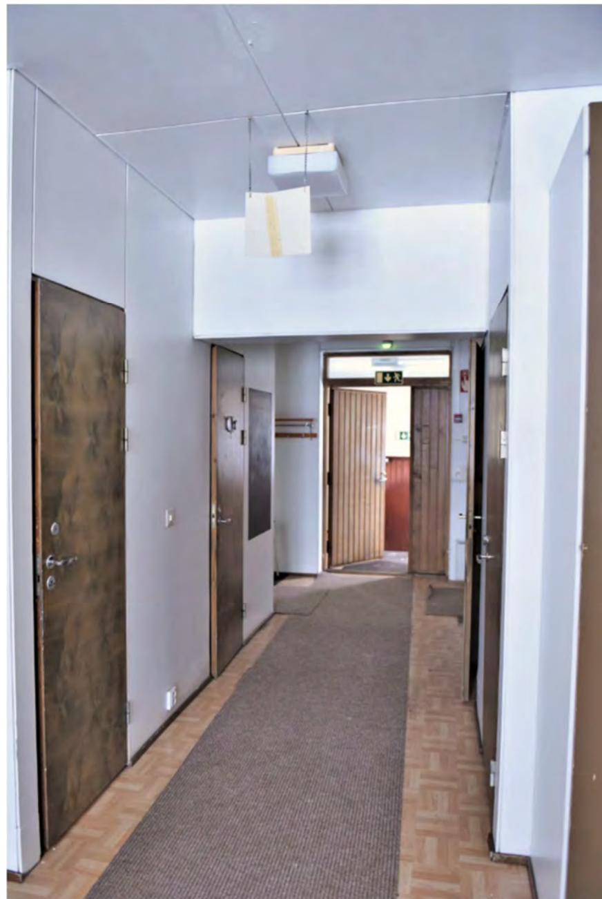
Huone 11 Vanha porstua ja keittiö on yhdistetty tilaksi, johon vastakkain rakennetut WC:et ja suihkutilat luovat käytävän.
