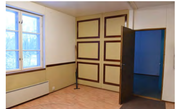
Kuva: Huoneen peilipaneelijäljitelmät on tehty puulistoin Luja-levylle.
