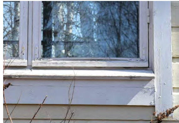
Kuva: Heloitus on eri-ikäistä, mm. saranoita on uusittu.
