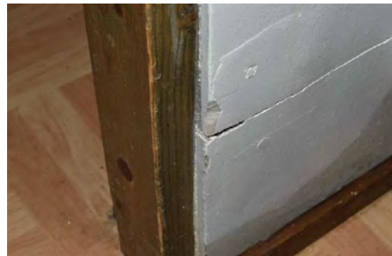
Kuva: Luja-levyn harmaa sementtikuituaines on kovahkoa, hienojakoista massaa.
