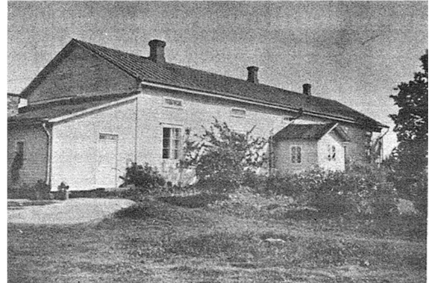
Kuva: Kinnarin päärakennus vuonna 1971. Tuolloin kuistin ikkunat olivat koristeelliset, julkisivut vaakalautoitettu, ikkunat kuusiruutuiset, vesikate oli jo pellistä, vesijärjestelmänä jalkarännit ja syöksytorvet keruusuppiloin. Pohjoispäädyssä oli lisärakennus. / Kuva Kianstén-suvun sukuselvityksestä.
