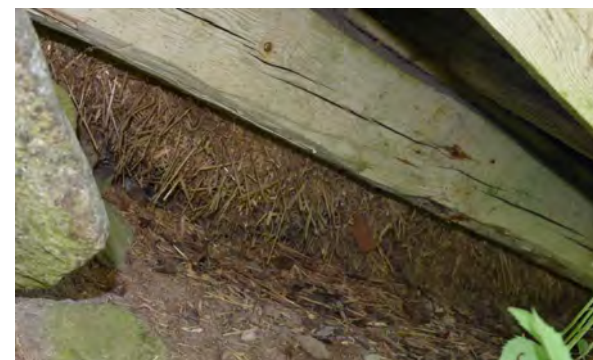
Kuva: Vesikaton vanhaa veistohirsistä tehtyä rakennetta. Katon eristeenä on maata ja olkia.
